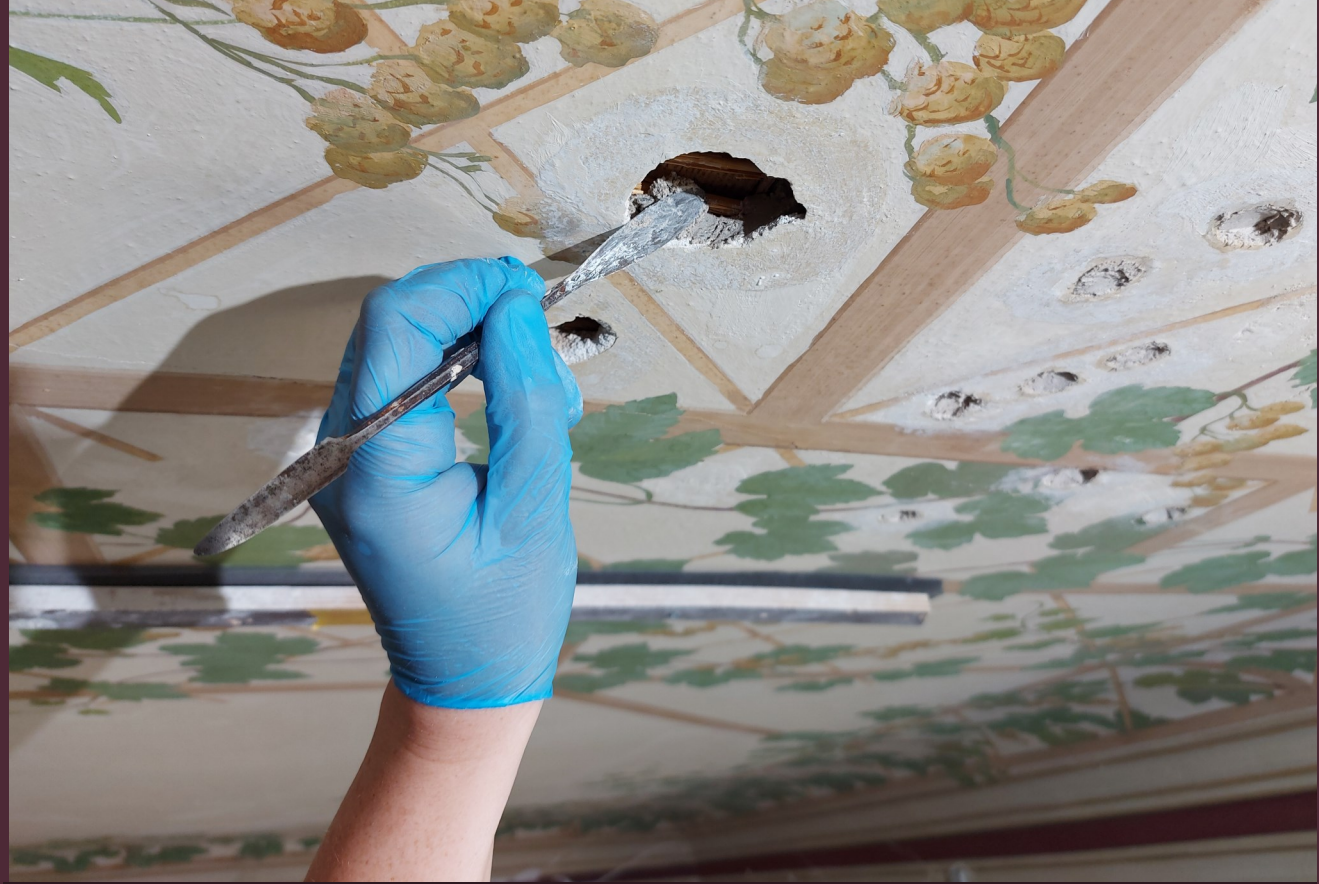
En stor del af restaureringsarbejdet består i at sikre ustabile pudspartier. Derudover bliver alle skader i loftsdekorationen lukket med kalkbaserede mørtler. Mørtlen lægges i med små murerskeer, der er specialfremstillet til modelleringsarbejde.
